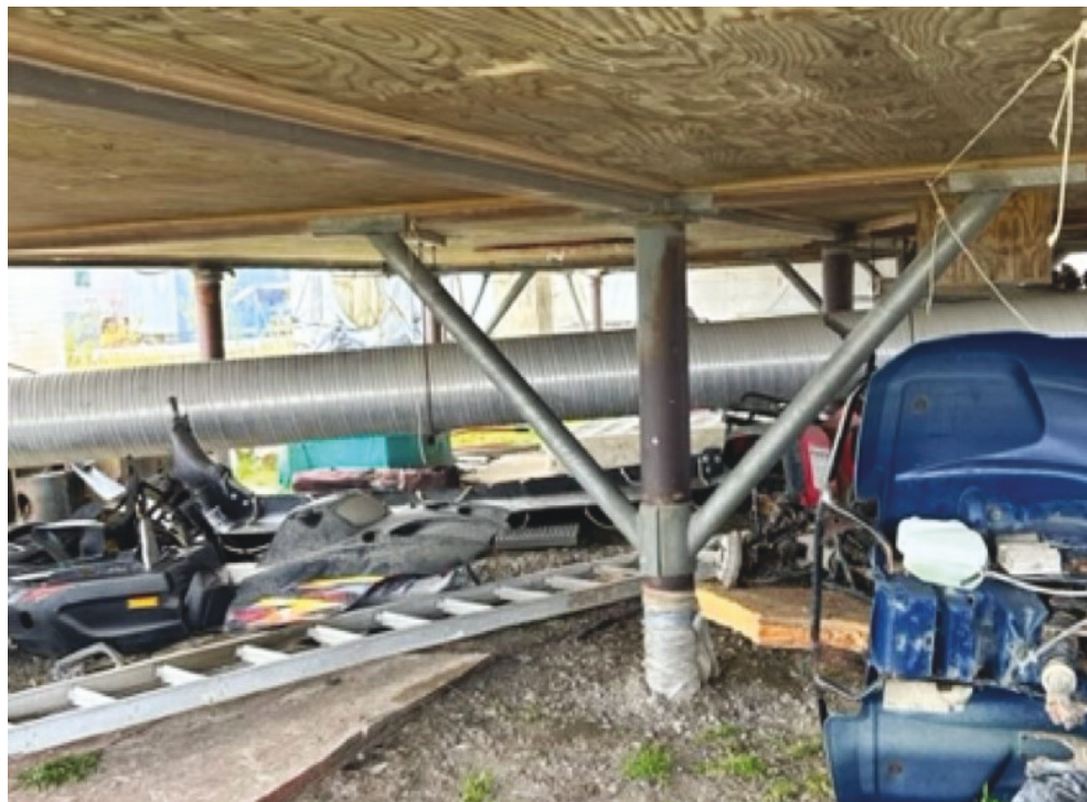
Рис. 4. Стальные сваи под домами в Куинхагаке
