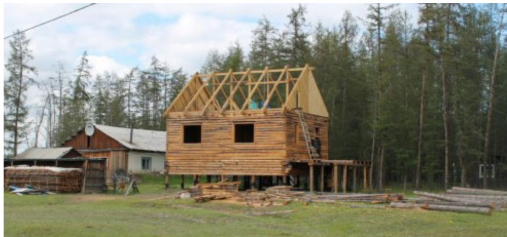
Рис. 2. Строительство домов на сваях в с. Бетенкес Верхоянского района (фото Филипповой В.В., 2013 г.)
