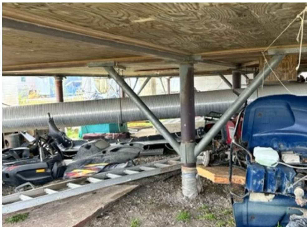
Рис. 4. Стальные сваи под домами в Куинхагаке
